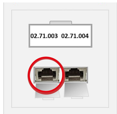
Abb 47: Anschlussdose mit seiner spezifischen Nummerierung (Beispiel: Anschlussdose 3 im Telematikzentrum).
