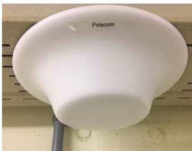
Abb. 17: Beispiel einer Polycom-Rundstrahlantenne (links) und einer Rundstrahlantenne für die Mobiltelefonie (rechts)
