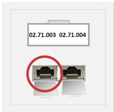
Abb 11: Anschlussdose mit seiner spezifischen Nummerierung (Beispiel: Anschlussdose 3 im Telematikzentrum)
