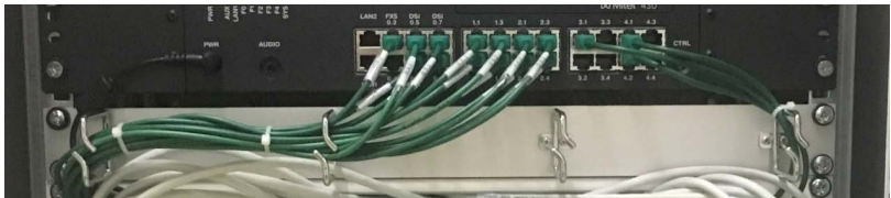
Abb 6: Frontansicht des Mitel 430 mit Ports für externe Verbindungen
